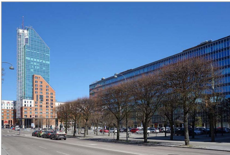
Skrapan och Melkerkontoret har helt olika uttryck men delar ambitionen att vara unika byggnader i Västerås stadsbild. Numera tillhör de också stadens signaturbyggnader.
