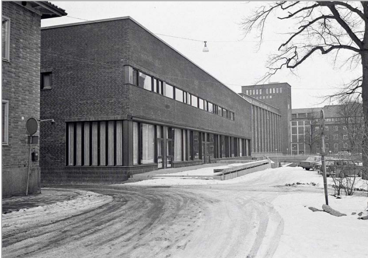
Södra fasaden med Norekontoret i bakgrunden. Fasadmaterialet är detsamma men uttrycken är diametralt olika. Foto: Bertil Forsén, ur Västerås stadsarkiv.
